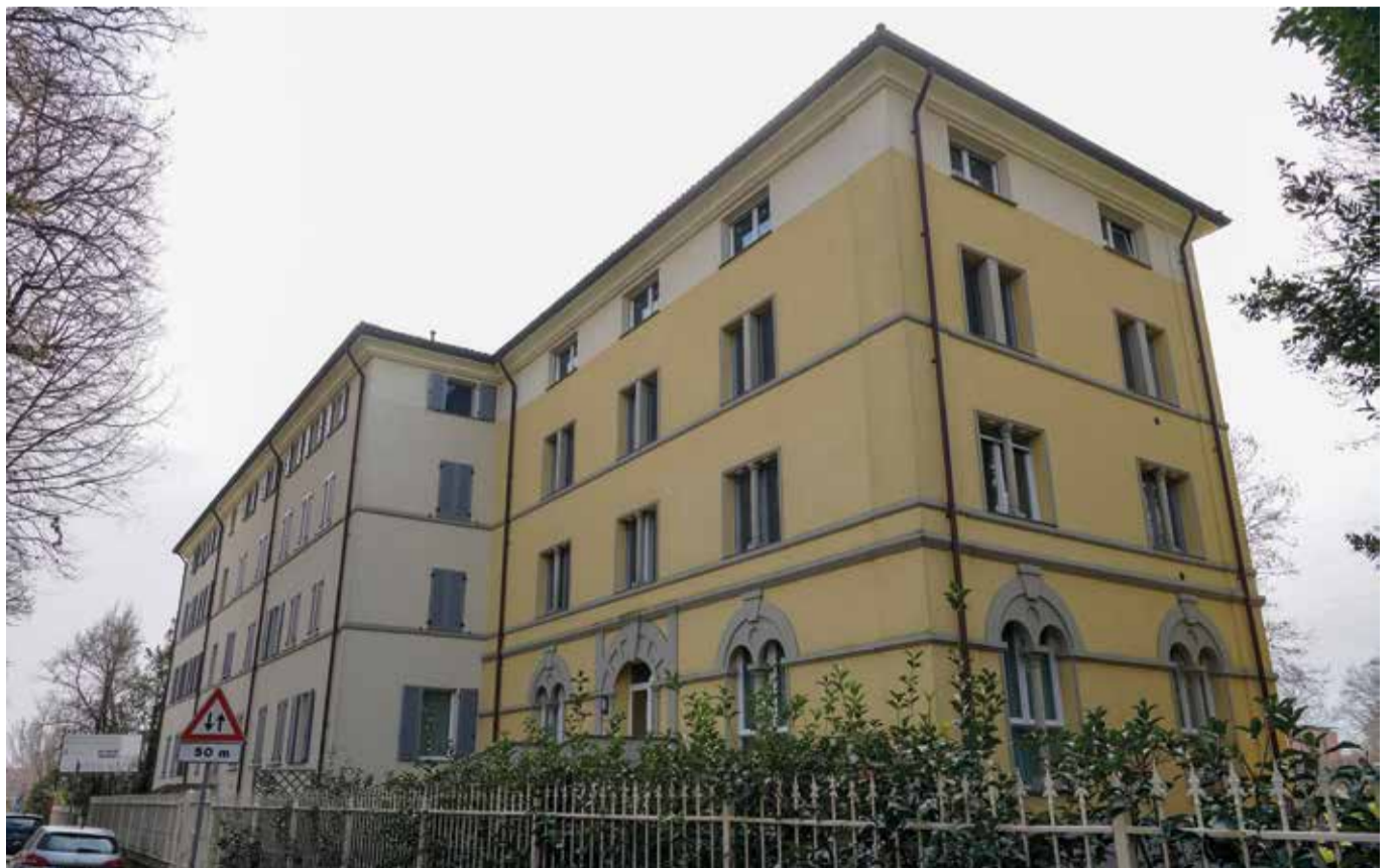
La Casa del Sacro Cuore è stata trasformata in abitazioni private, pur mantenendo l'aspetto originale.
