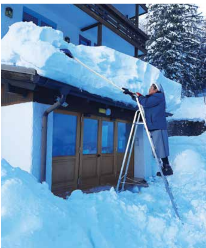
Sr Respha alle prese con la tettoia del Bar
