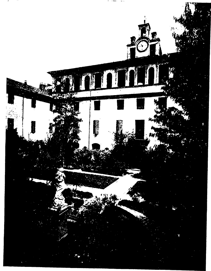
Parma - Collegio Sant'Orsola - Facciata interna.
